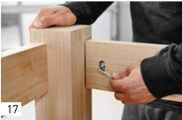
Затяните соединение ключом-шестигранником на 4 мм.
