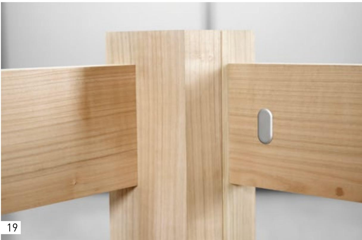
Вот так, быстро, без трудоёмких измерений и нанесения разметки, получается надёжное соединение, которое при необходимости можно быстро разобрать.
