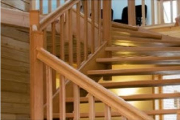
**СОВЕТ** Разумеется, стойки можно соединять с поручнем и под углом, например, на перилах лестничного марша. Для этого выставьте на фрезере DOMINO угол, под которым будут фрезероваться пазы под шипы DOMINO в стойках.
