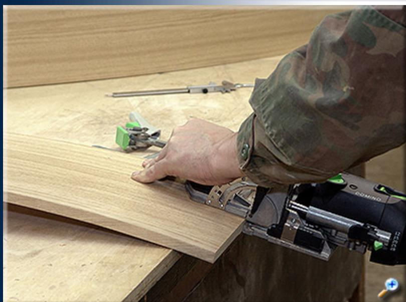
Соединение брусков с панелями будет происходить при помощи вставных шипов.
