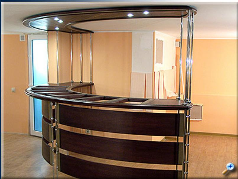
Столешницу подсвечивают 12 вольтовые лампы, проводка проходит через трубы.
