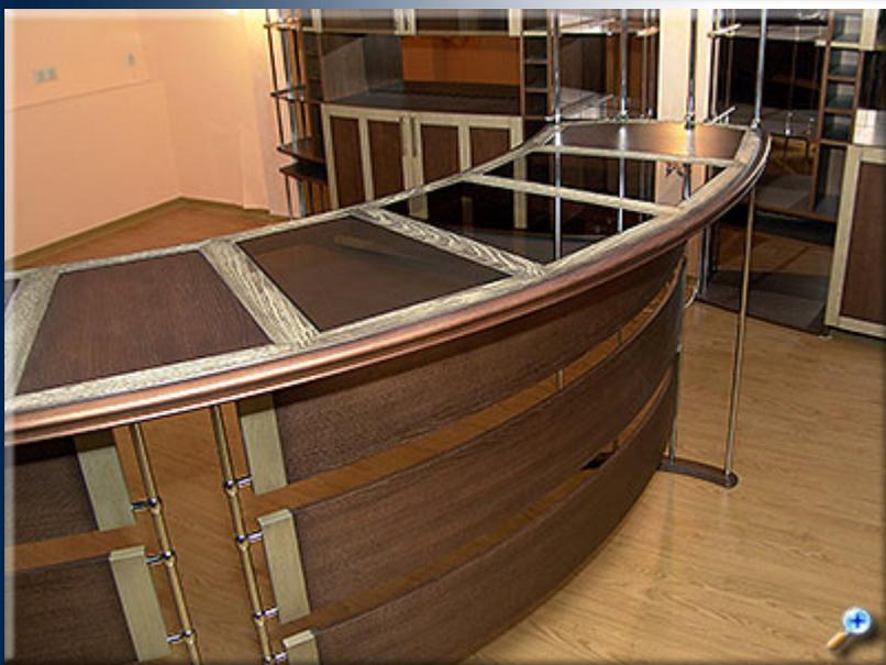
Установка стекол в ячейки столешницы.
