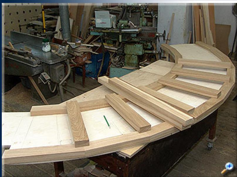
Все заготовки выкладываем на подготовленный заранее шаблон. Шаблон изготовлен из 15 мм фанеры по форме столешницы барной стойки.
