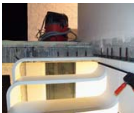
16 Ausrichten und befestigen der Stufen an einem Metallwinkelprofil
