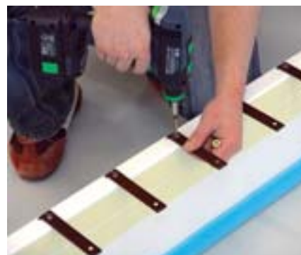
15 Eine zusätzliche Schraube hält die in die Nut eingesetzten Ankerlaschen
