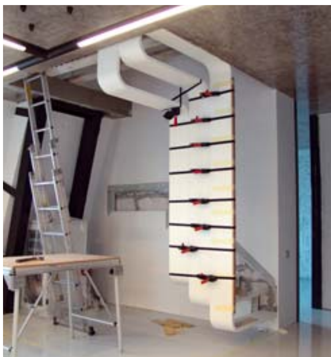
19 Die Montage beginnt mit dem Element, das die unterste und oberste Treppenstufe bildet. Danach geht es weiter in Richtung Podest
