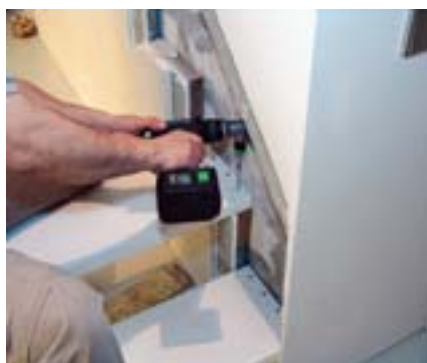
17 Verschrauben der Treppenstufen auf Auflagehölzern hinter der Gipskartonplatte
