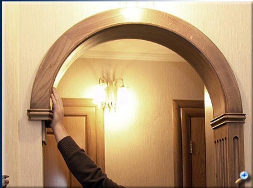
Установка арки в проем проходит в два этапа. Предварительная установка с необходимой подгонкой и окончательная, во время которой внутренняя часть элементов заполняется монтажной пеной.
