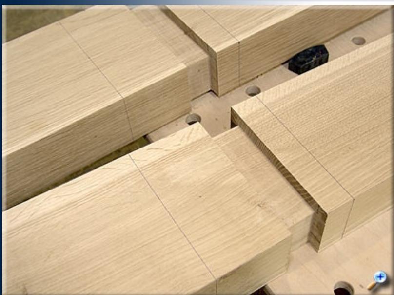
Теперь пилястры разделены на две зоны. Паз, предназначенный для декоративной обвязки, при необходимости может использоваться для крепления арки к стене.
